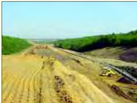
Mit schwerer Technik bewegte die STRABAG fast drei Millionen Kubikmeter Kies und Erdstoffe für die Sanierung des Tagebaus Zwenkau
