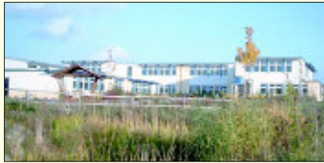
Das Freie Gymnasium Zepernick – unbeschwertes Lernen in modernen Gebäuden
