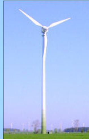
In der Feldmark um den Ort wird Windenergie gewonnen
