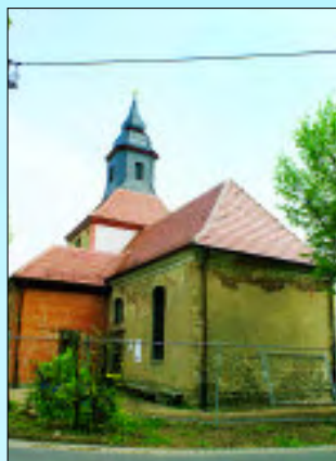
Bald wird die Kirche in neuem Glanz erstrahlen
