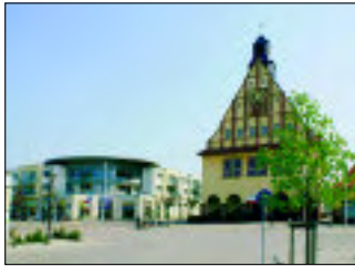
Blick auf das sanierte Rathaus
