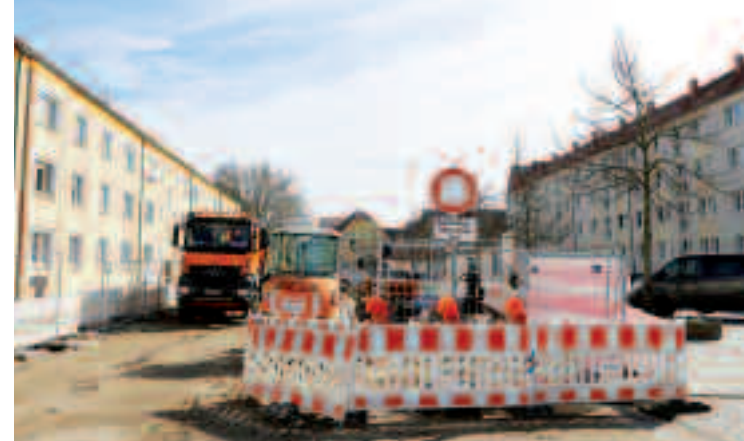
In der Steinstraße wird in mehreren Abschnitten gebaut. Bis ins kommende Jahr müssen die Prenzlauer hier Geduld haben.
