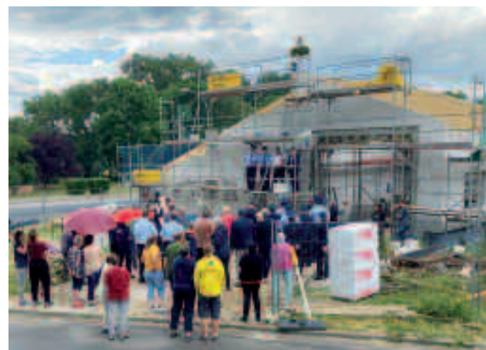
In Dauer wurde im vergangenen Jahr Richtfest gefeiert – in diesem Jahr wird das neue Feuerwehrgebäude fertiggestellt.
