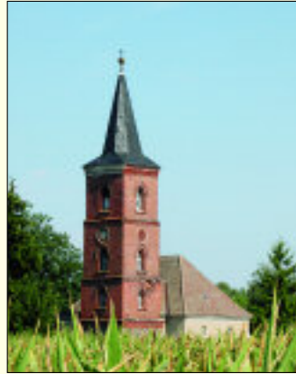
Haages Dorfkirche - restauriert nach Kugelblitzschlag 1962
