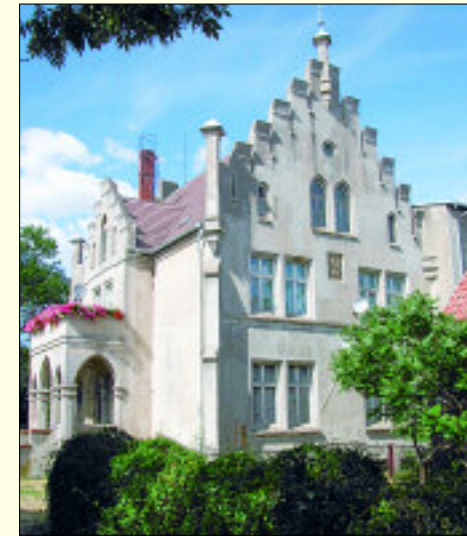
Das, was vom Schloss Vietznitz noch steht
