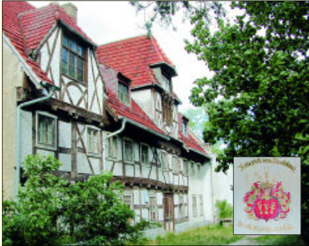
Unter Denkmalschutz und verwaist, Knoblauchs Herrenhaus
