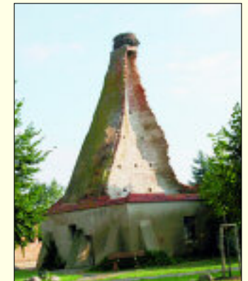
Schornsteinrest der Schlossküche, der „Schwedenturm“
